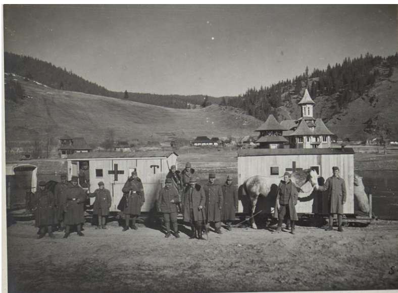
Fig. 4- Rollbahn vom 11 K.K. (Umspannstelle Gura Negri) Sursa: https://digital.onb.ac.at/rep/osd/?112AA76D
